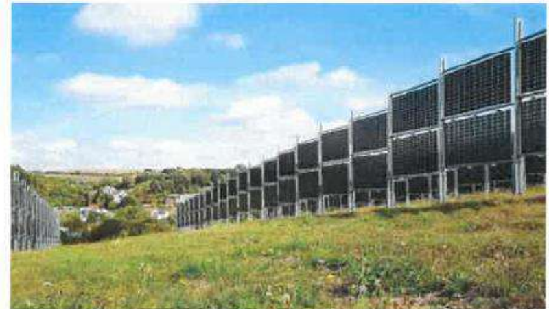
Bild 35: Bifaziale, senkrecht aufgestellte Module von Next2Sun,
